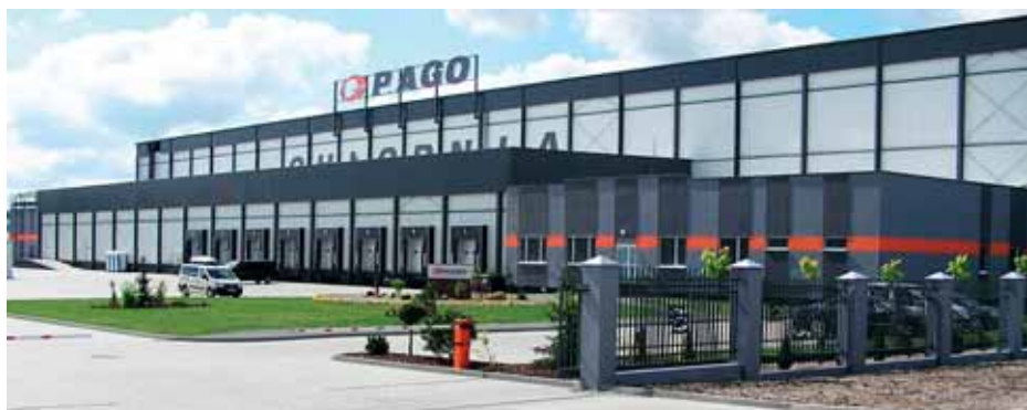
Widok frontowej części nowej chłodni w Łęborku (fot. A. Olejniczak).
